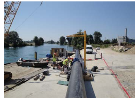
Cornaux, au bord du canal de la Thielle Soudure des tuyaux en PE Ø 800 mm
