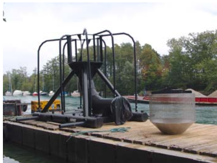
3 ème étape de transport par bateau Après avoir passé sous la voie CFF Fin des travaux de soudures
