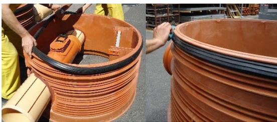
**Insertion du joint d'étanchéité (point 4)**
