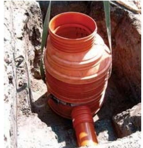
**Figure 5 :** Pose d'une chambre prête à être remblayée.
